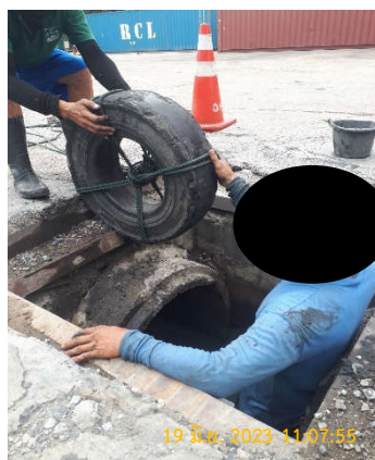
รูปถ่ายที่ 3.2-19 : การขุดลอกตะกอนดินจากท่อระบายน้ำ
